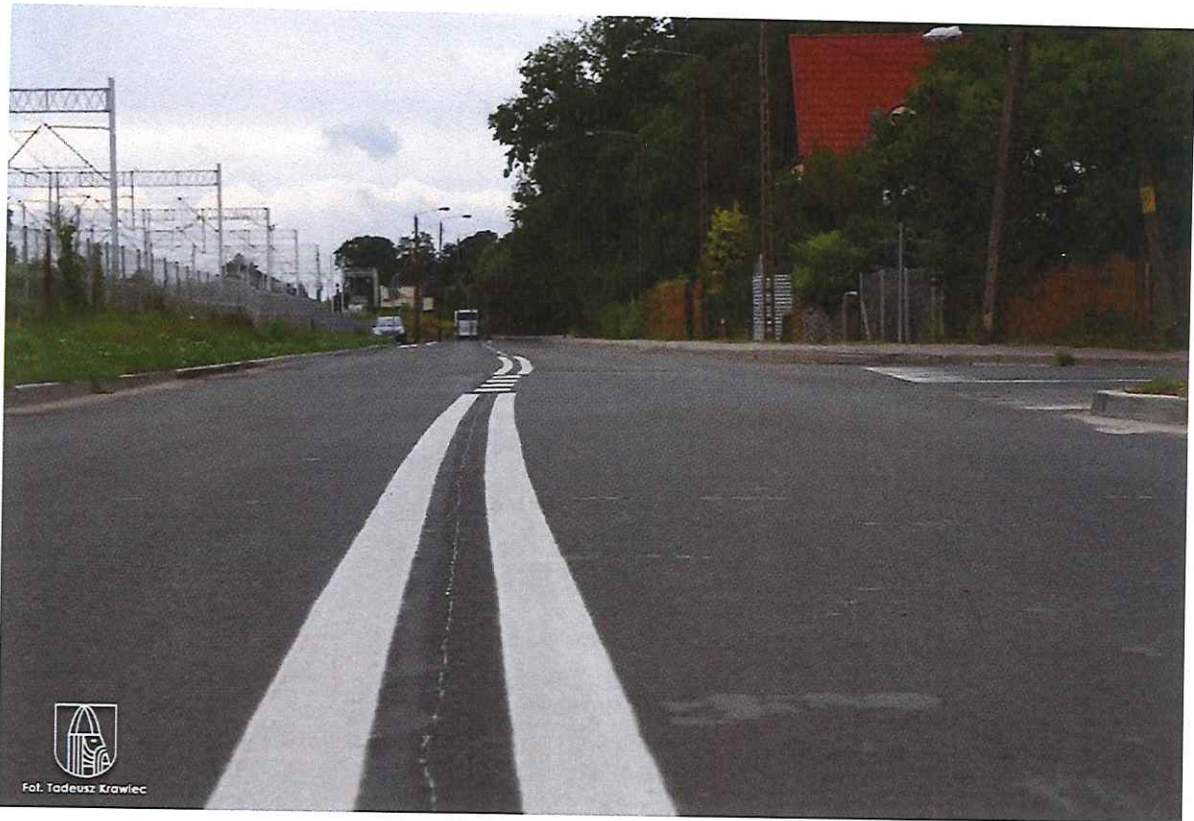
BUDOWA ULICY POGODNA
