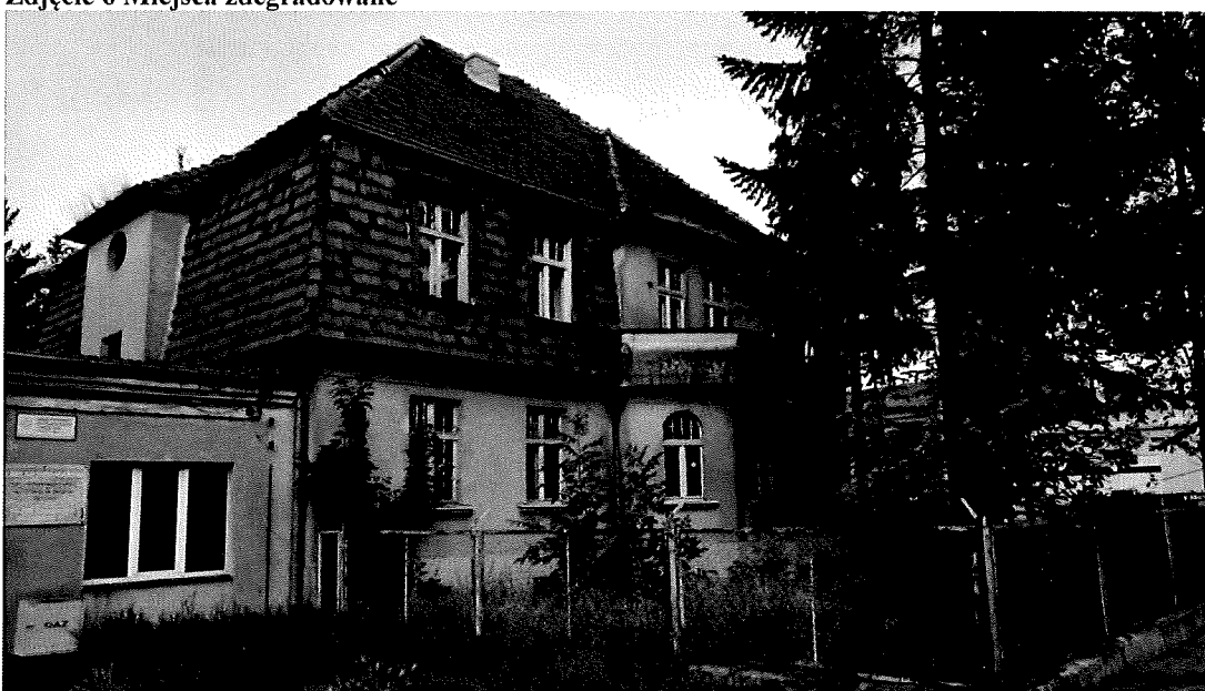
Zdjęcie 6 Miejsca zdegradowane
