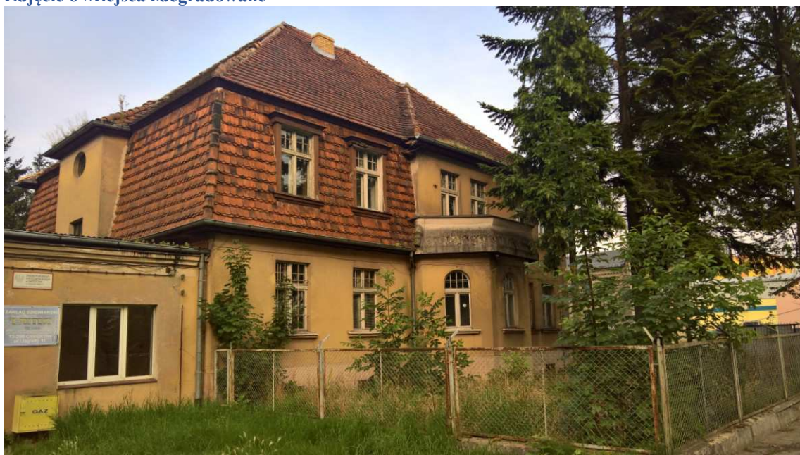
Zdjęcie 6 Miejsca zdegradowane
