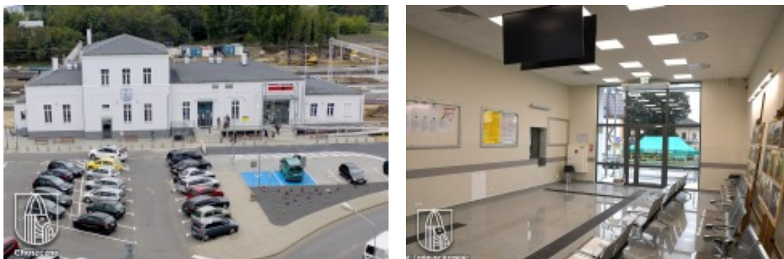
Zdjęcie 4 Rewitalizacja budynku dworca PKP w Choszcznie
