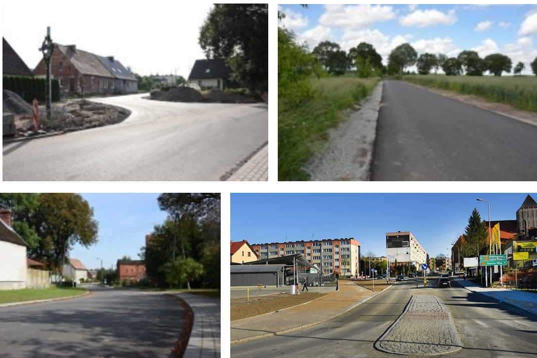
Zdjęcie 3 Przebudowa dróg gminnych
