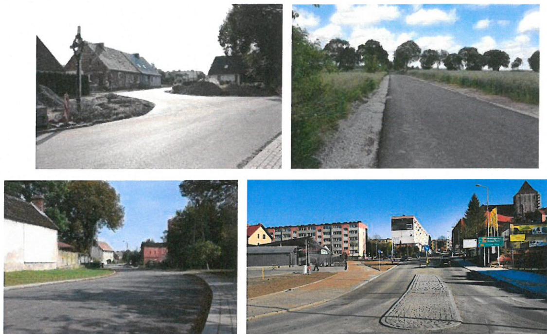
Zdjęcie 3 Przebudowa dróg gminnych
